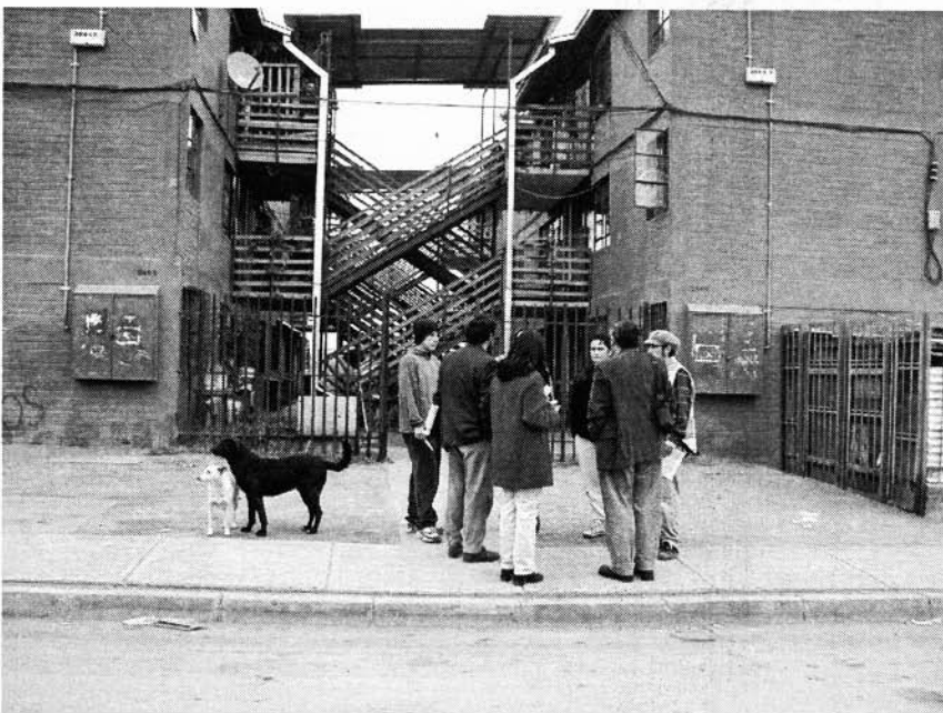
PROGRAMAS DE VIVIENDAS BÁSICAS (PVB) EN ALTURA MEDIA. PUENTE ALTO, SANTIAGO CHILE
