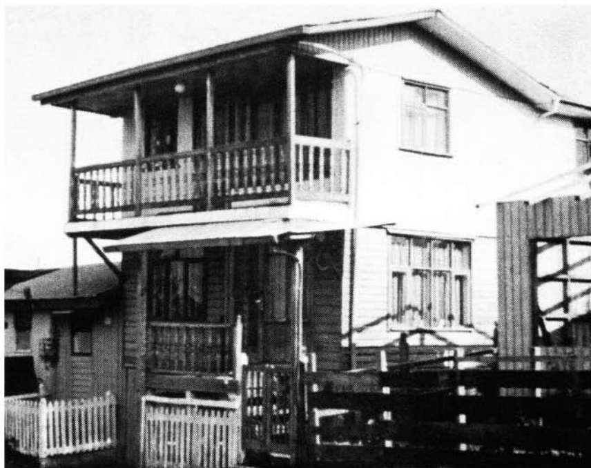
MEJORAMIENTO HABITACIONAL REALIZADO POR LOS PROPIOS POBLADORES A PARTIR DE PROGRAMAS ESTATALES DE VIVIENDA. POBLACIÓN CONDELL, OSORNO, CHILE.
