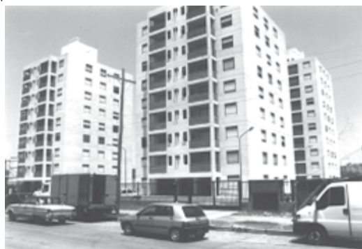
FIGURA 13: Vista de conjunto de la Cooperativa Personal Subterráneo. Fuente: PMH, FADU, UBA y Dirección de Catastro del GCBA. 1999. Fuente: PMH, FADU, UBA.
