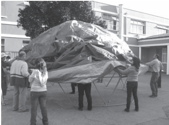
FOTO 11. montaje de cubierta San Vicente T.T.
